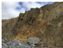
8034 - zone de fracturation oxydée dans granite porphyroïde (palier 3)
