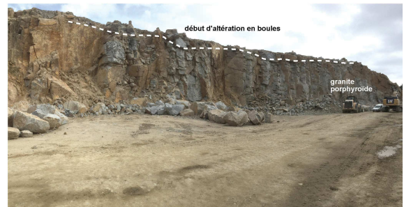
8036 - vue générale du palier supérieur - granite porphyroïde avec début d'altération en boules dans la partie supérieure
